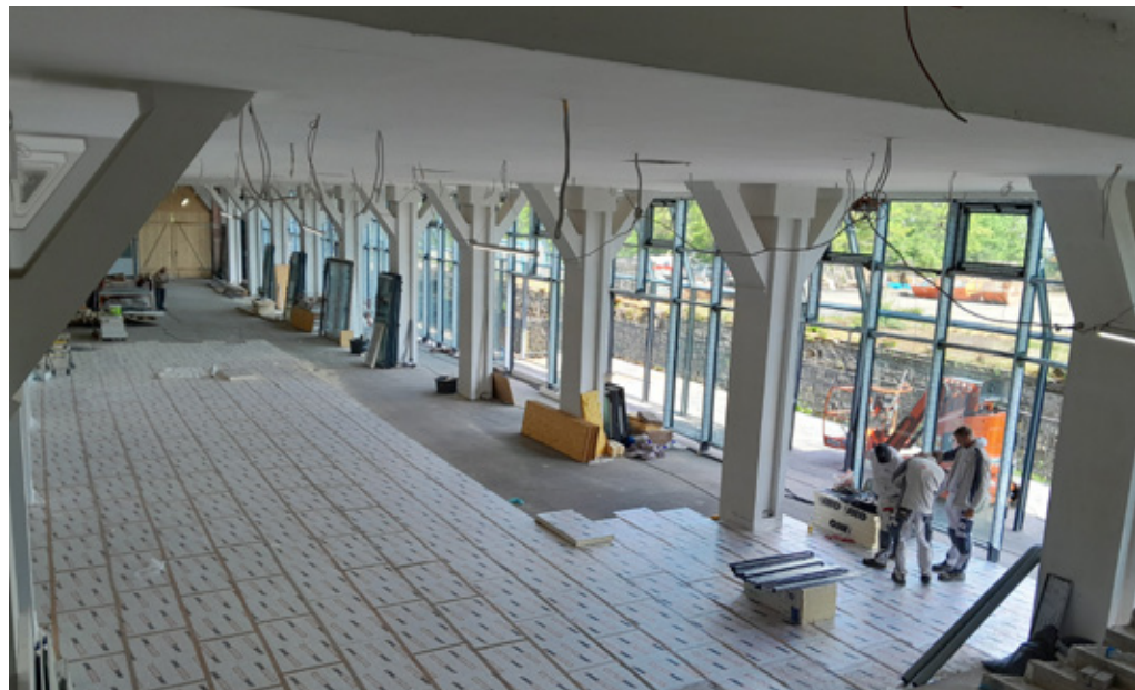
Noch liegt viel Arbeit vor den Handwerkern. Hier entsteht das Restaurant.
