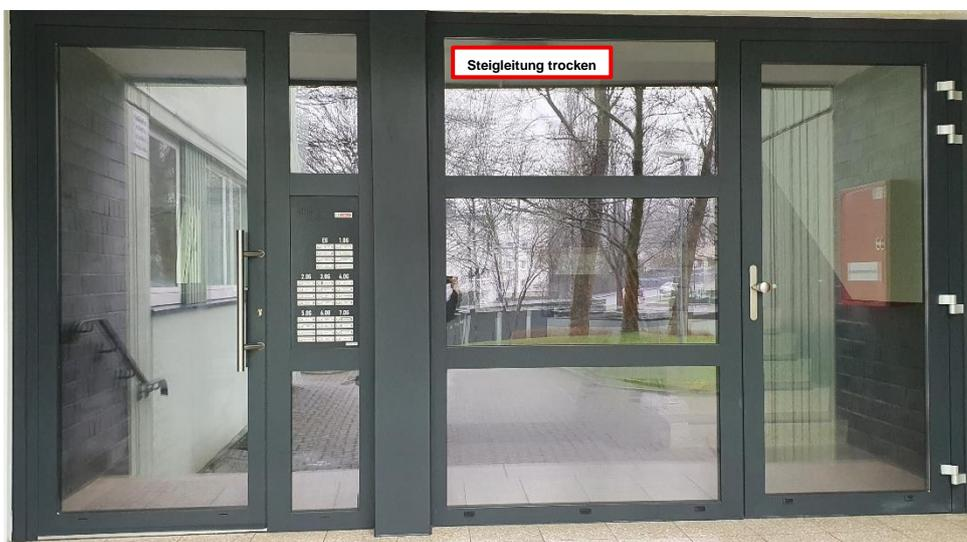
Abbildung 2: Hinweisschild zur Kennzeichnung einer Steigleitung trocken an einer Hauseingangstür
