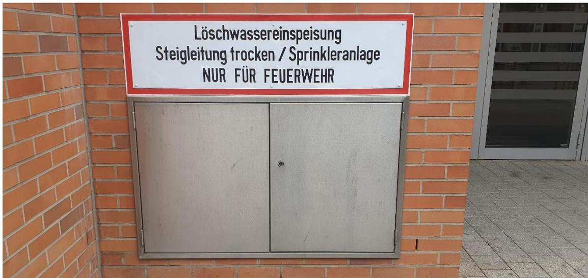
Abbildung 8: Kennzeichnung einer kombinierten Einspeiseeinrichtung
