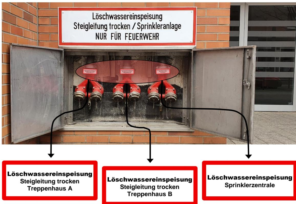
Abbildung 9: Kennzeichnung einzelner Einspeiseeinrichtungen verschiedener Löschanlagen in Kombination
