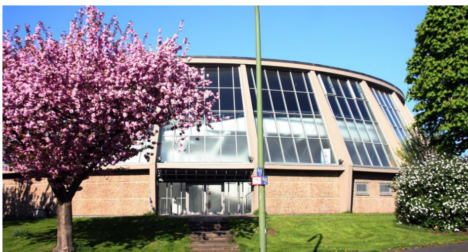
Elseyer Rundturnhalle (Foto: Pressestelle der Stadt Hagen)
