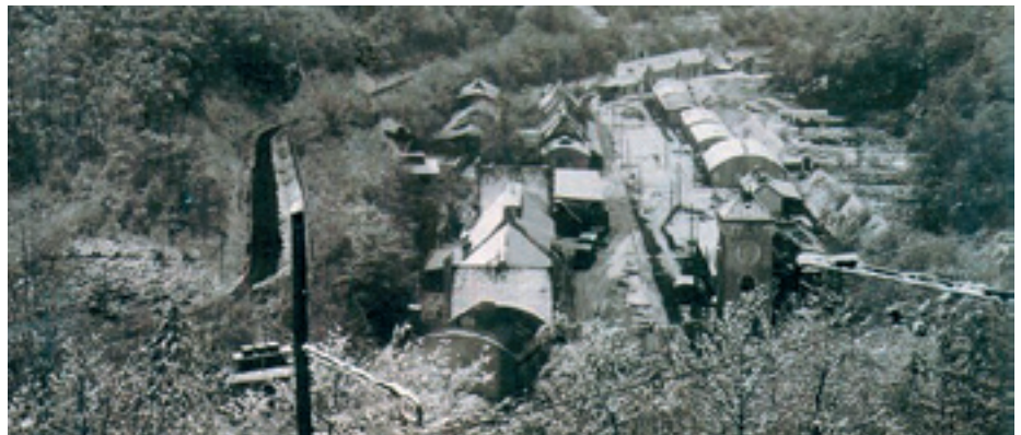
Sprengstoffwerke im Sterbecketal.
