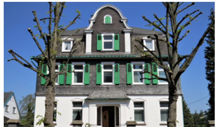
Die Eversbusch-Villa an der Berliner Straße. Die Georg-Kraus-Stiftung lässt das unter Denkmalschutz stehende Gebäude zu einer Wohngemeinschaft für Menschen mit Demenz umbauen.
