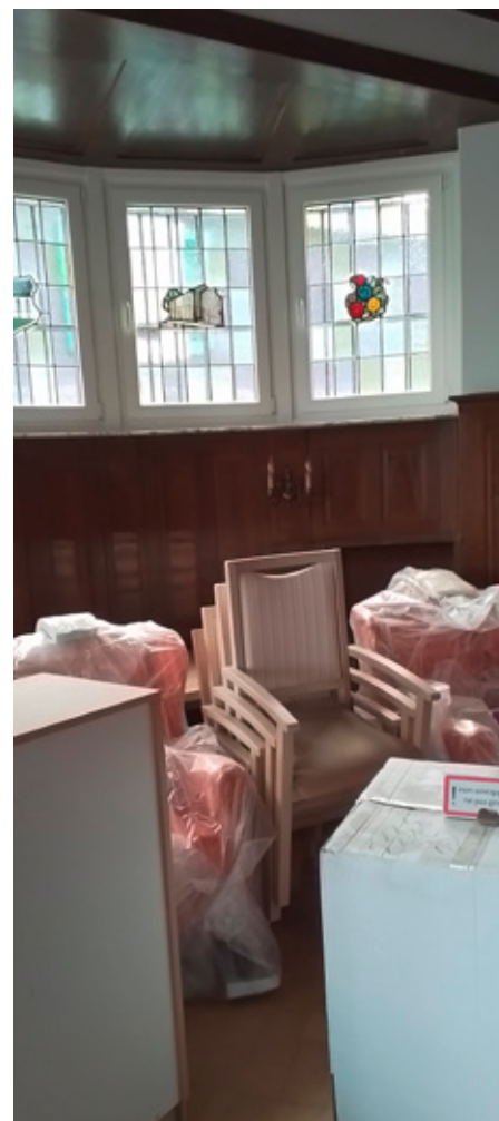
Blick in die Villa während des Umbaus
