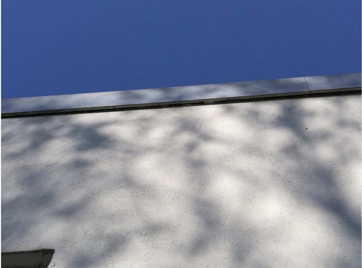
*Abbildung 6: Spalte zwischen Dachaufkantung und Gebäudewand*
