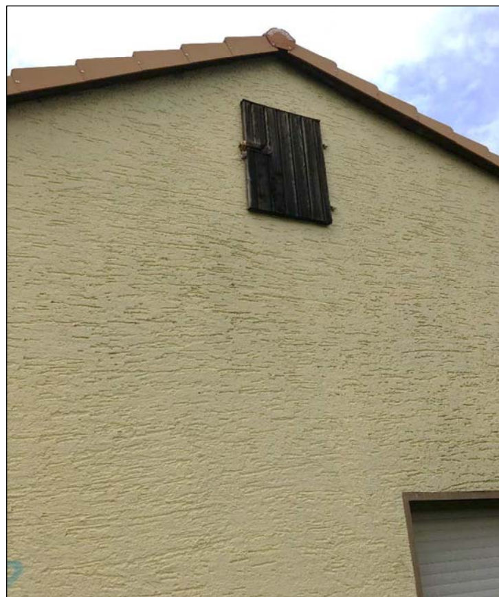
Abbildung 9: Wohnhaus, südliche Giebelwand mit Luke zum Dachboden
