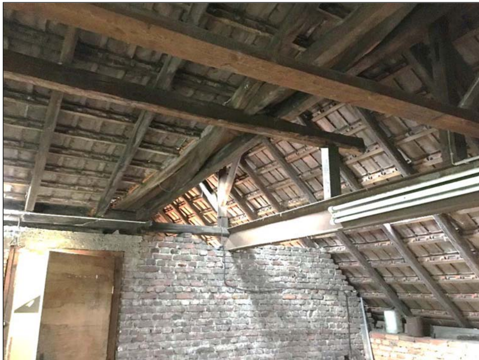
Abbildung 10: Geschäftshaus, Dachkonstruktion und offenes Ziegel-Mauerwerk
