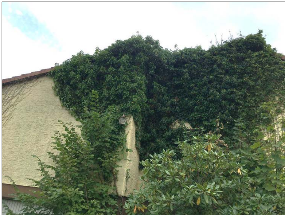
Abbildung 8: Wohnhaus, nördliche Giebelwand
