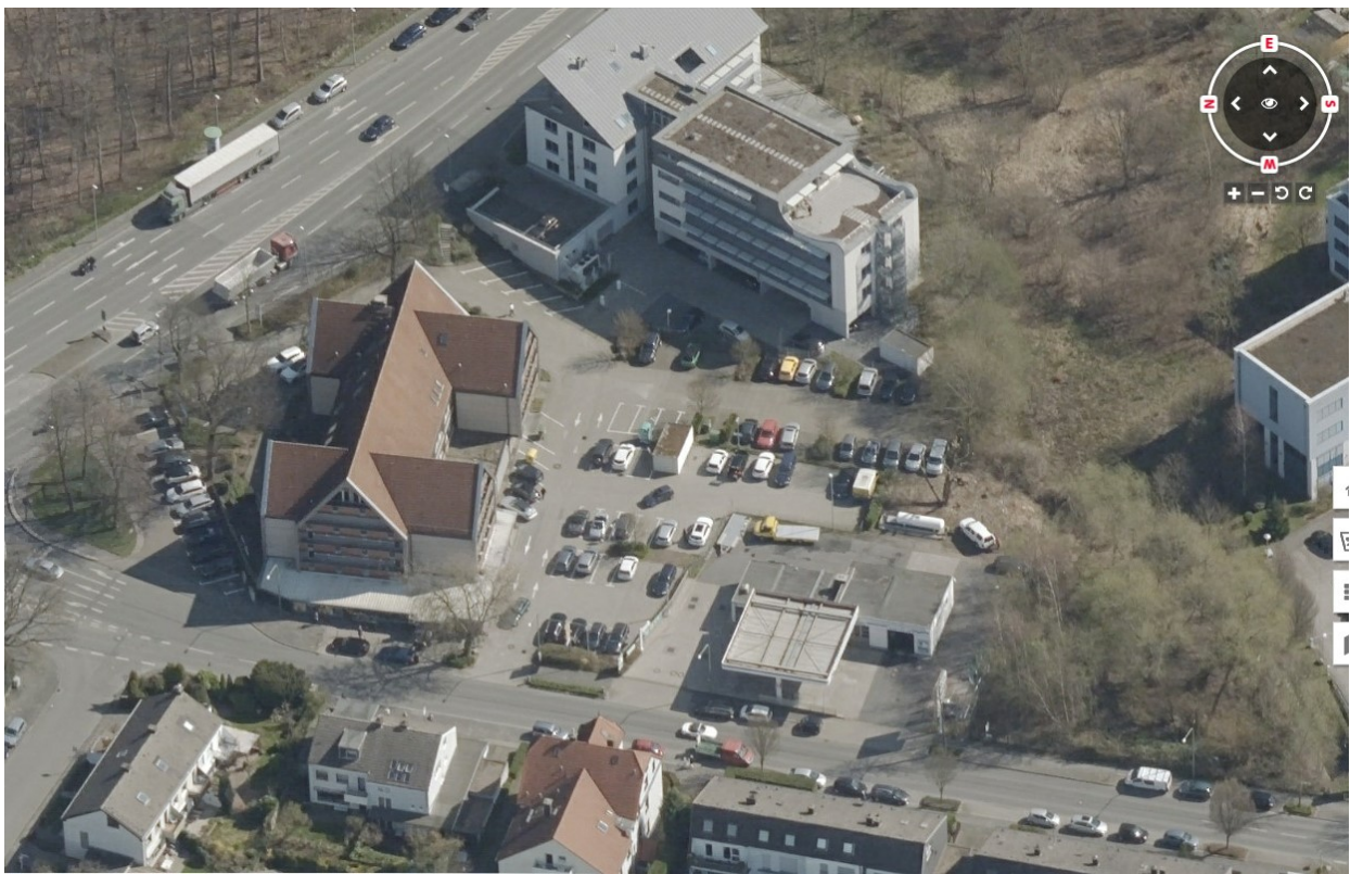
Ansicht von Westen (Fleyer Straße)
