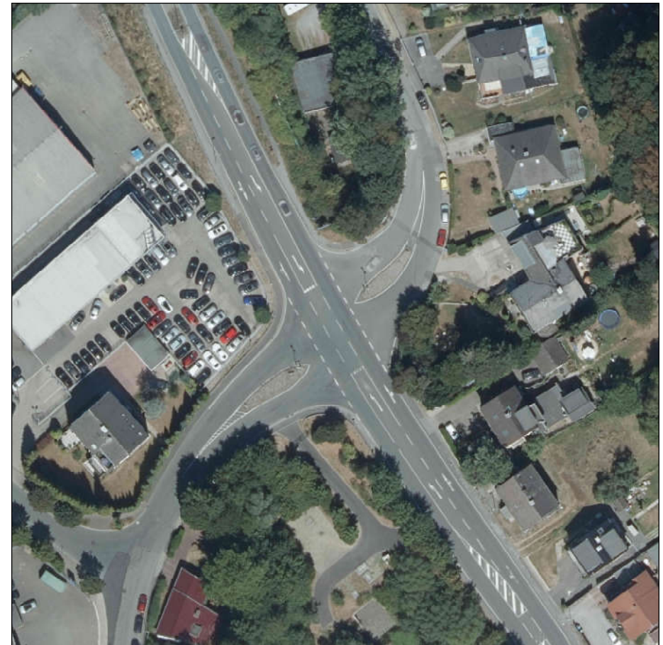
Bild 8: Luftbild Knotenpunkt L 807 / Altenhofer Weg / Heller Straße (Quelle: tim-online.nrw.de)
