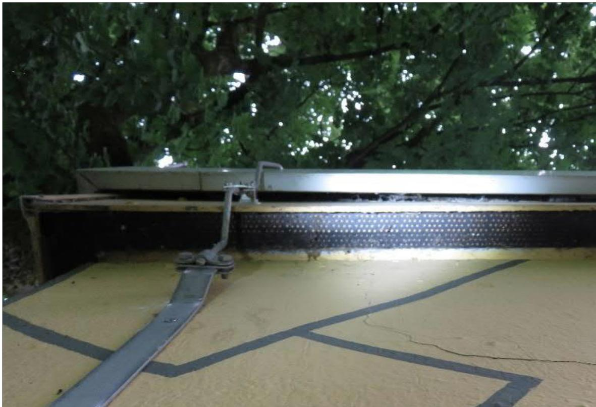
**Abbildung 5:** Spaltenräume zwischen Metallverkleidung und Fassade
