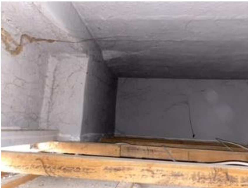
Bild 12: abgehängte Decke ohne Zugänge von außen
