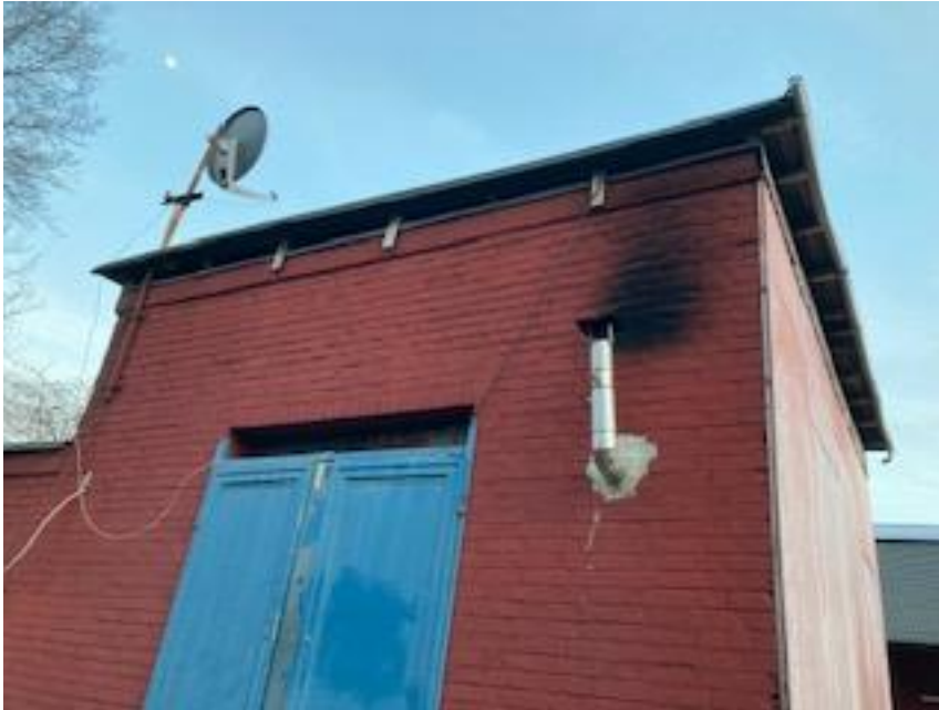
Bild 11: Einlässe unter dem Dach des Hauptgebäudes
