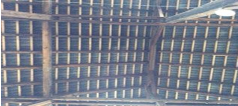
Bild 7: Dachstuhl alter Bahnhof
