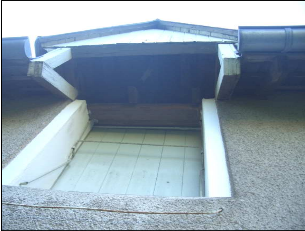
Abbildung 11: Einflugmöglichkeiten auf das Dach der Scheune, Nordseite.
