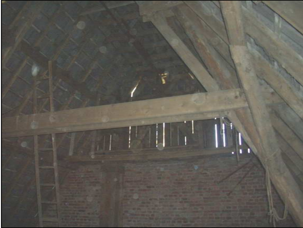
Abbildung 17: Blick auf die Westseite der Scheune (vgl. Abb. 12).
