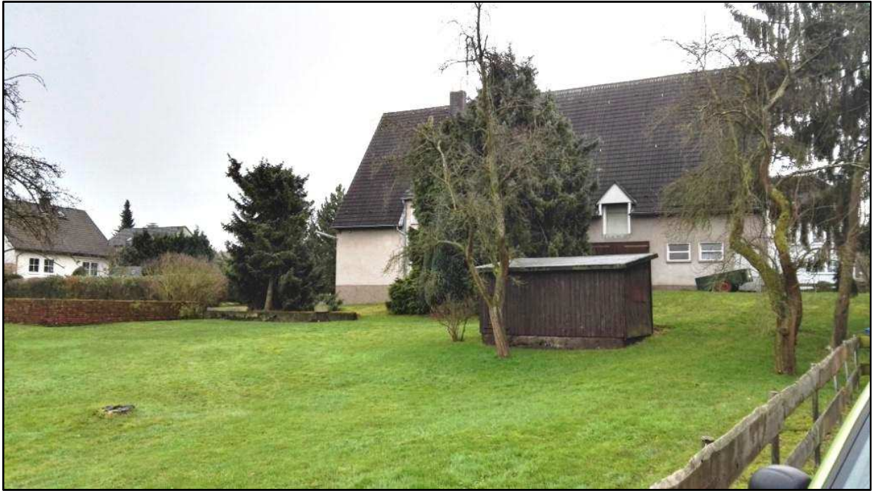
Abbildung 5: Blick nach Süden auf das Wohngebäude an der Buschstraße.
