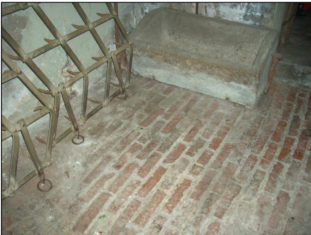
Abbildung 14: Fußboden im Erdgeschoss der Scheune.
