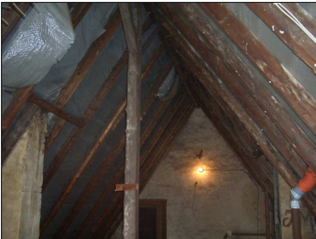
Abbildung 24: Nicht ausgebauter Teil des Dachstuhls des Wohngebäudes.
