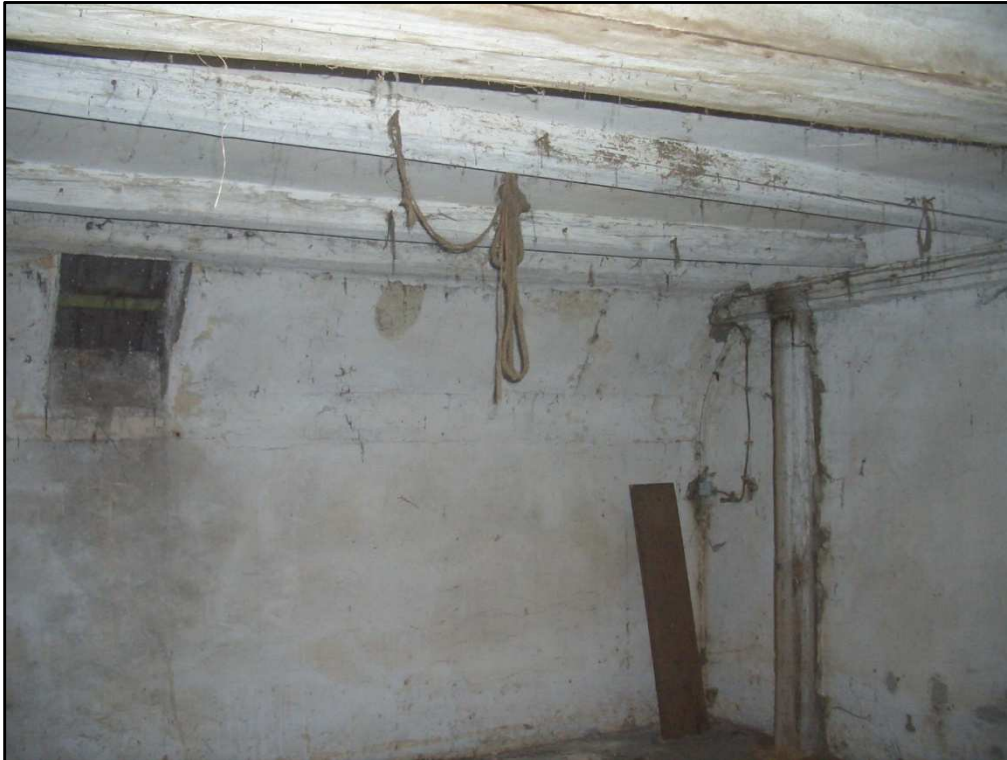
Abbildung 23: Nebenraum des Dachbodens der Scheune, ohne Tierspuren.
