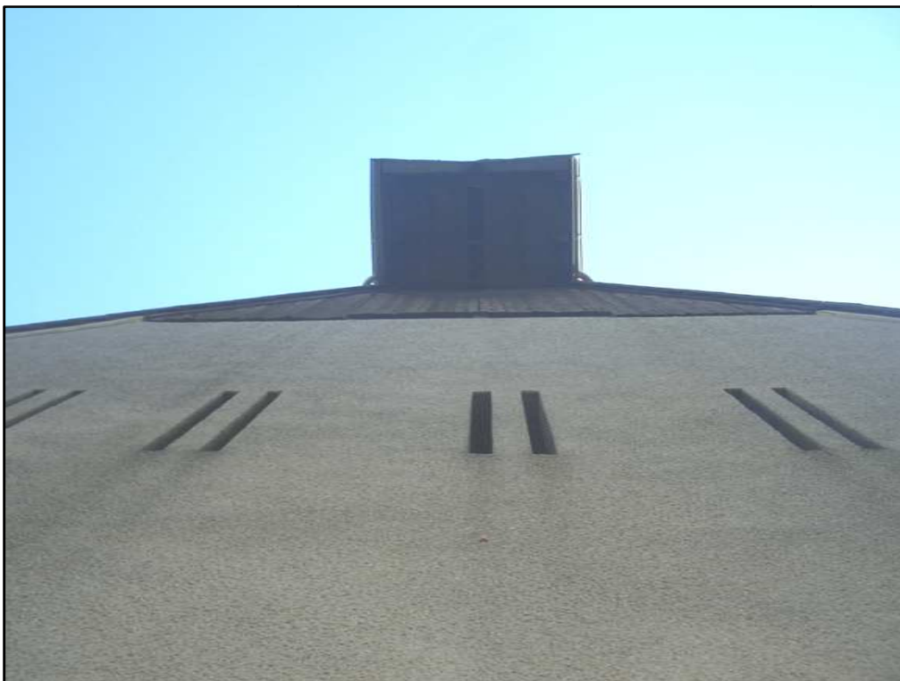
Abbildung 12: Einflugmöglichkeiten auf das Dach der Scheune, Westseite.
