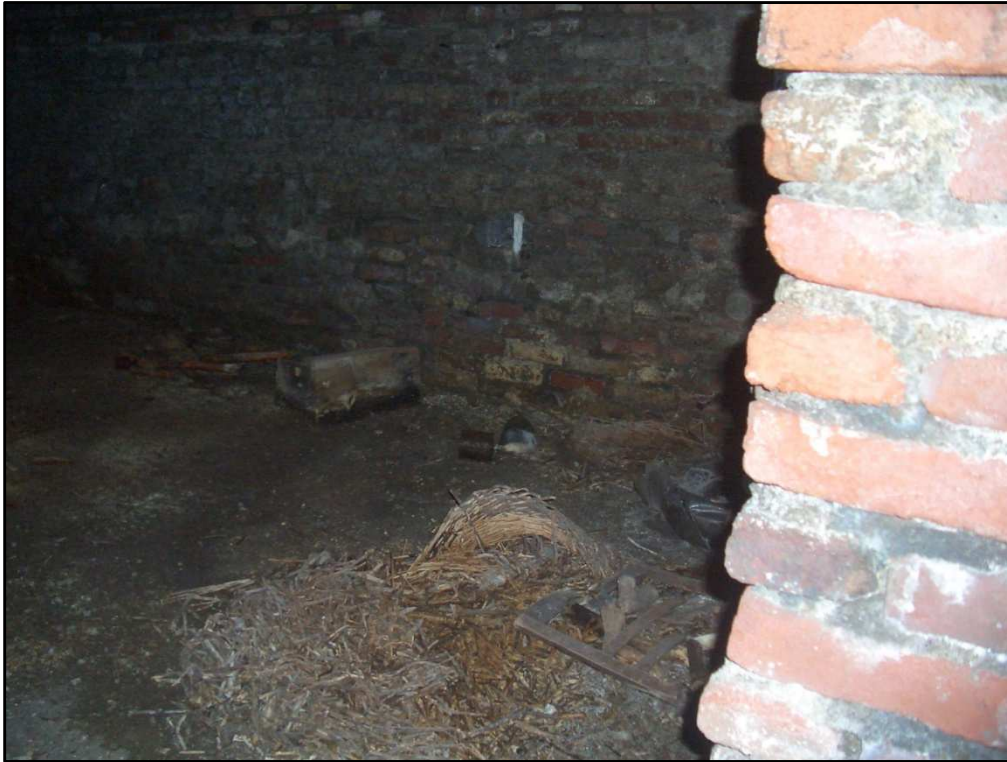
Abbildung 27: Kellerraum der Scheune.
