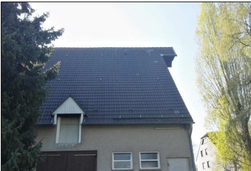
Abbildung 10: Einflugmöglichkeiten auf das Dach der Scheune, Nordseite.
