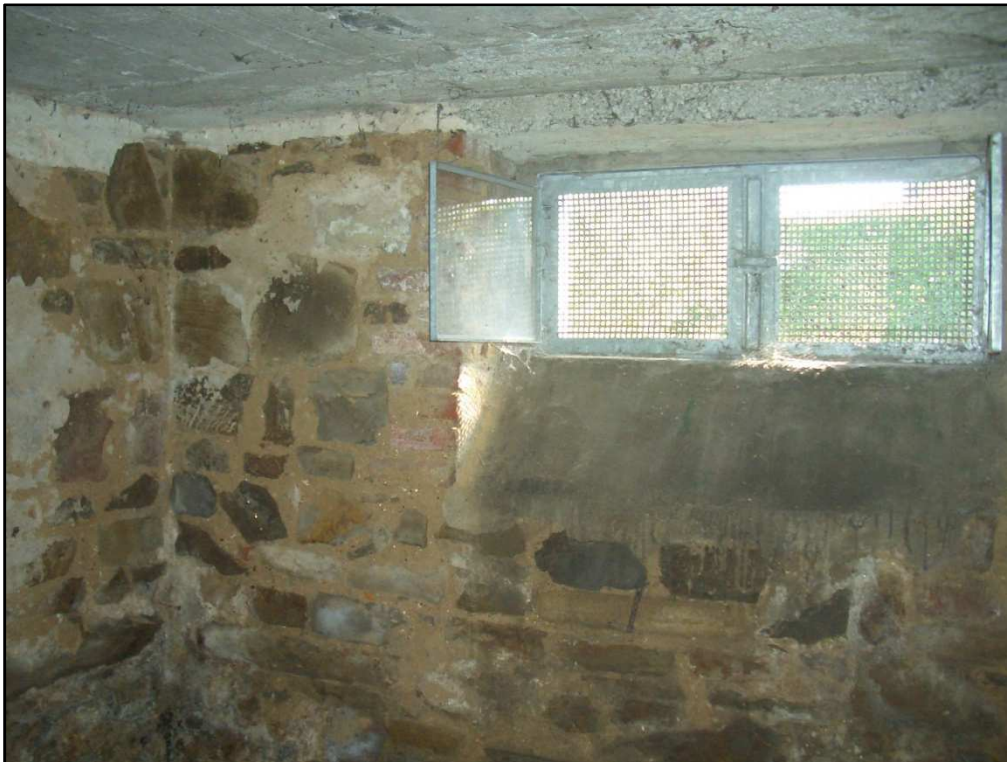
Abbildung 26: Kellerraum des Wohngebäudes.
