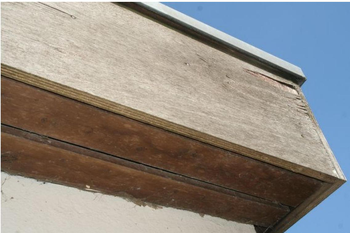
**Abb. 10: Umlaufende Dachkante mit Spalten**
