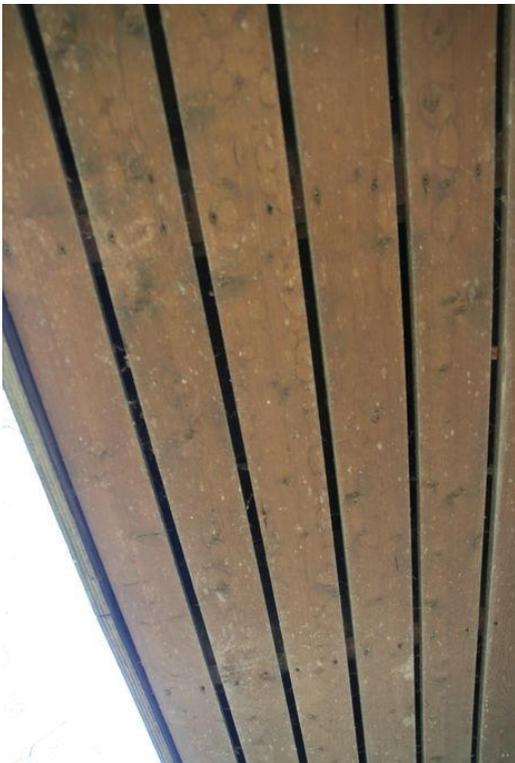
**Abb. 8: Spalten an der Unterseite der Dachverkleidung**
