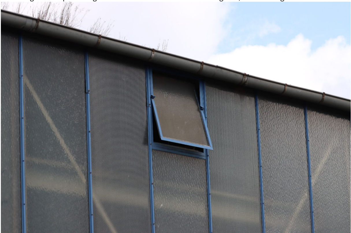
Abbildung 8 Altes Speditionsgebäude, Detailaufnahme
