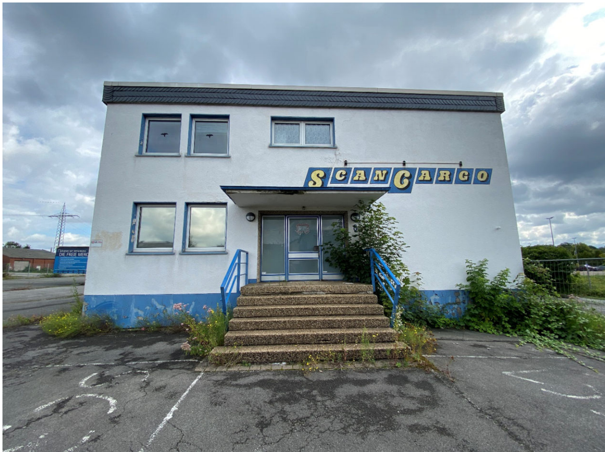
Abbildung 1 Altes Speditionsgebäude, Haupteingang, Blickrichtung NO
