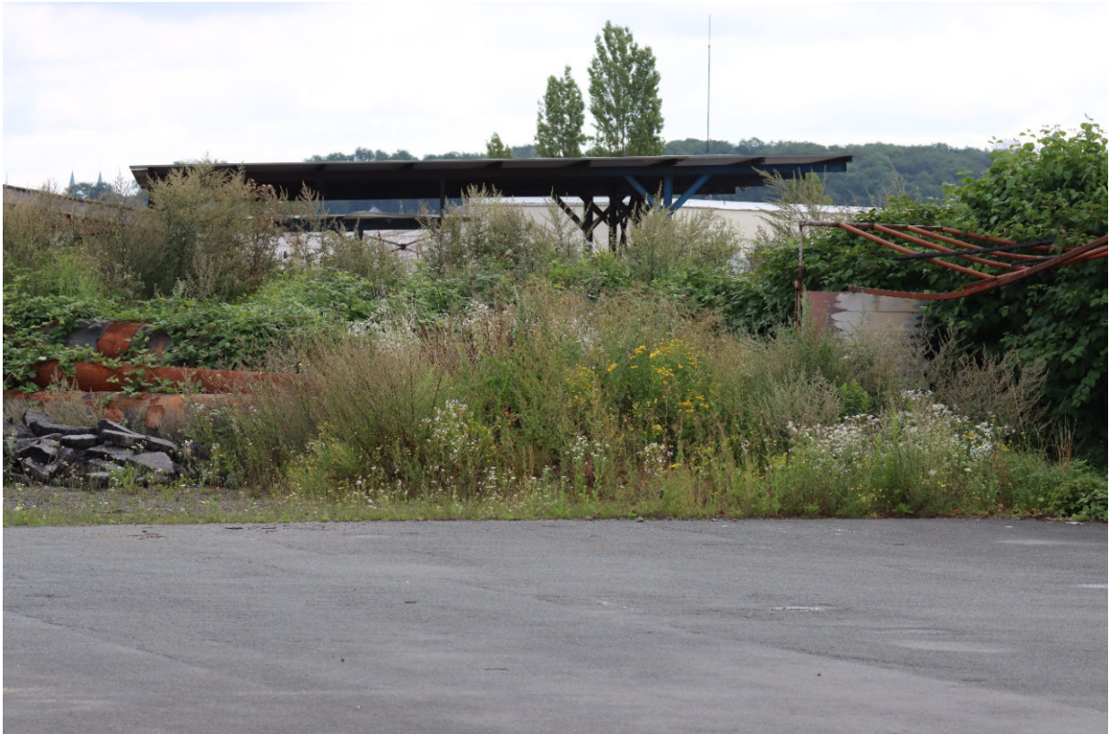
Abbildung 9 Randbereich Parkplatzfläche Speditonsgebäude, Blickrichtung O
