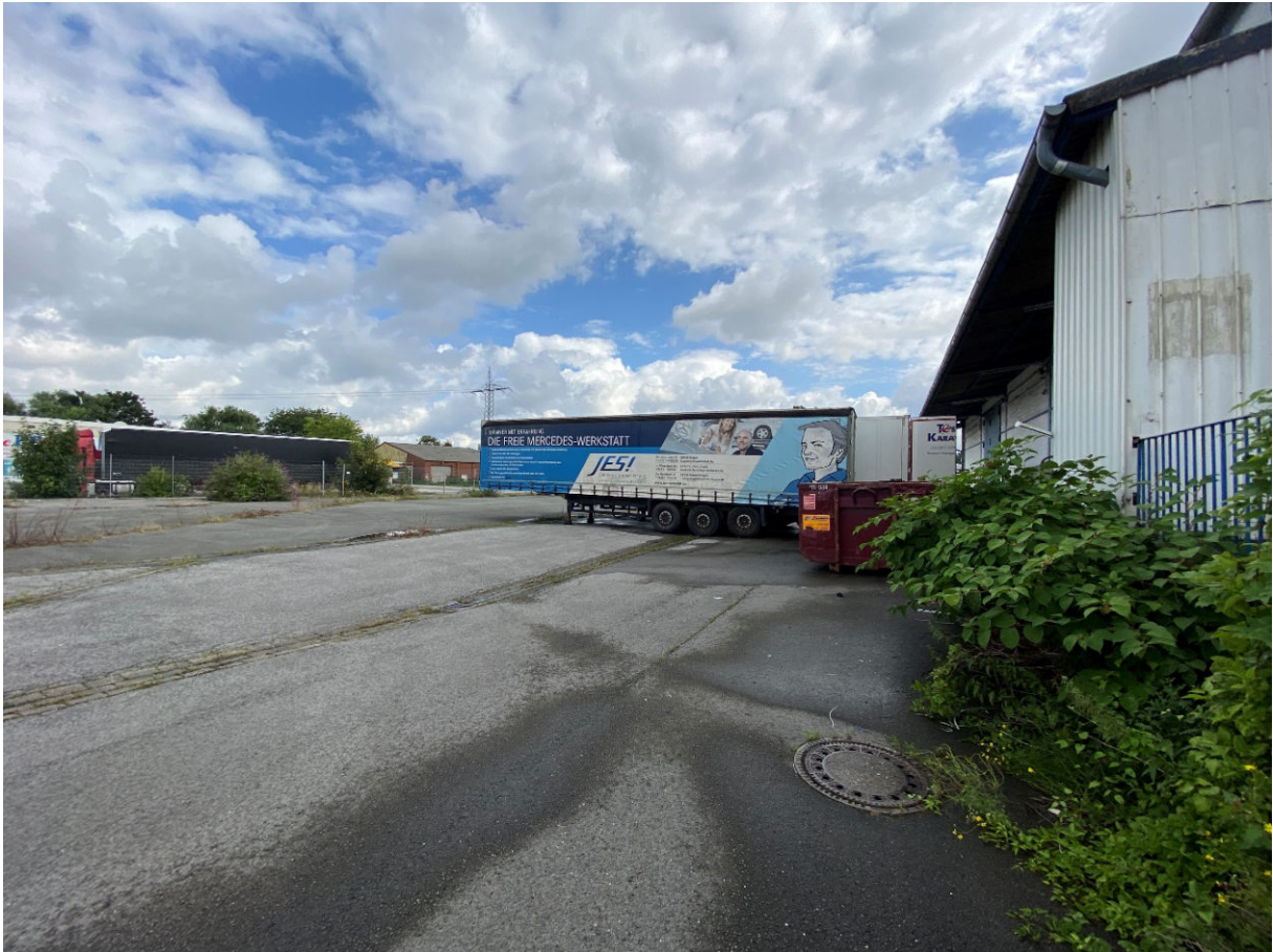
Abbildung 13 Parkplatzfläche Speditionsgebäude, Blickrichtung NO
