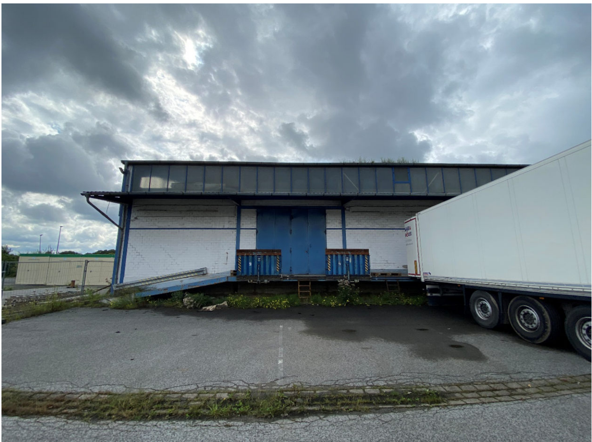
Abbildung 14 Parkplatzfläche Speditionsgebäude, Blickrichtung SO
