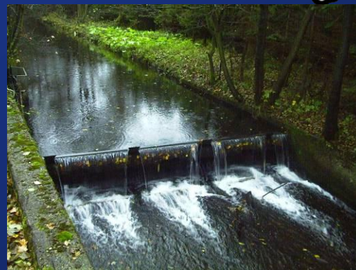
Wehr Stahlwerk Plate, km 12+679
