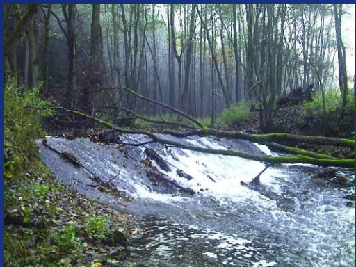
Wehr Trempershof, km 8+200
