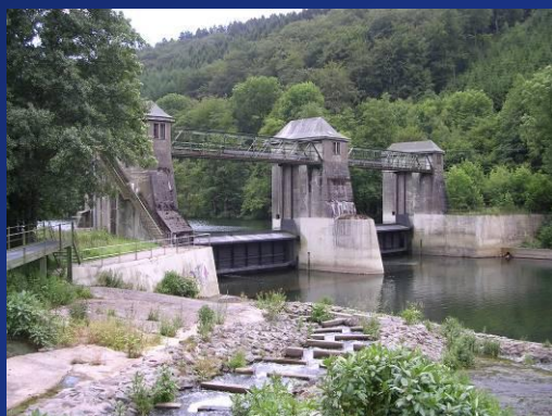
Wehr Wilhelmsthal, km 39+190
