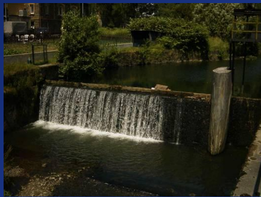
Wehr Bärenstein, km 6+795
