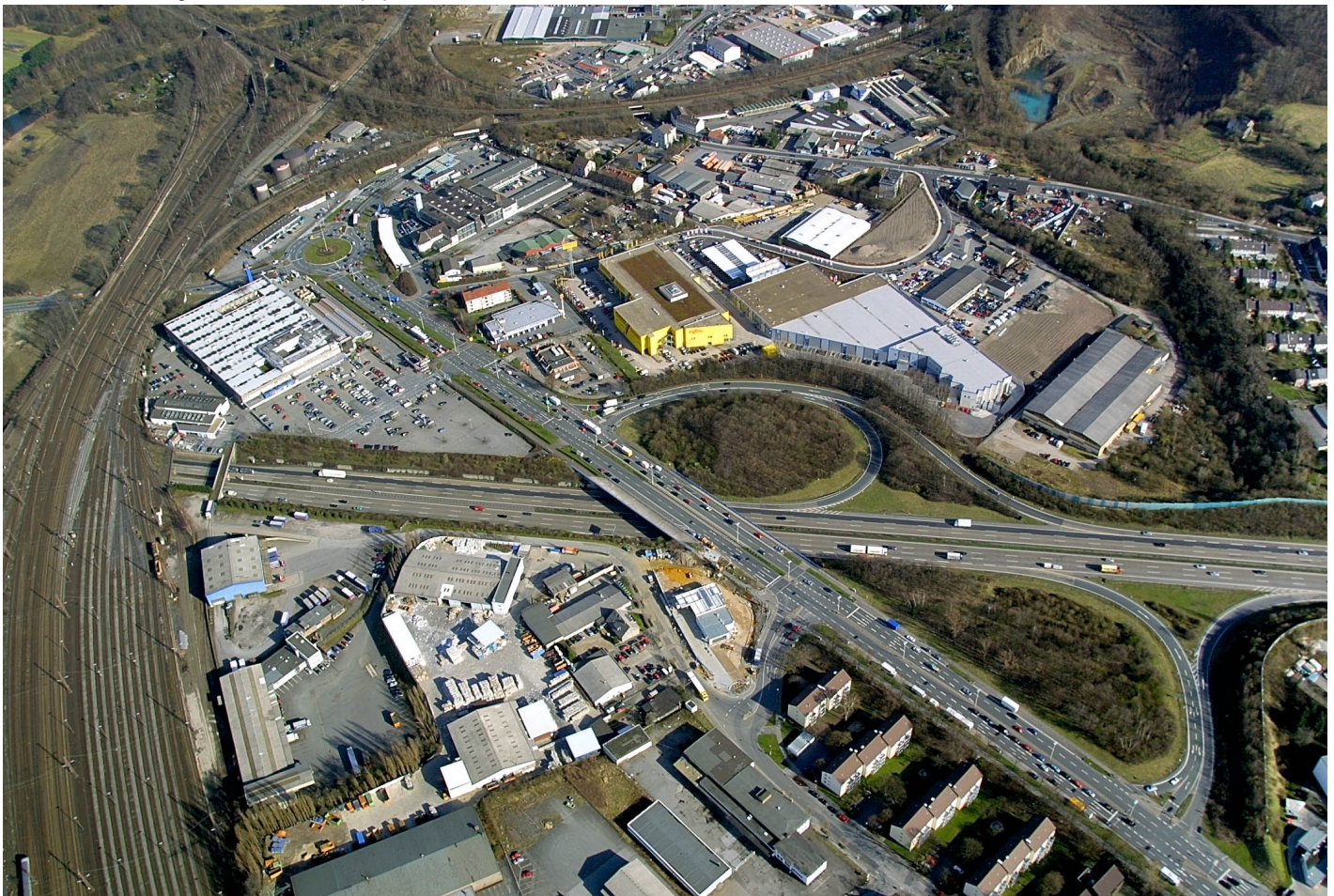
Autobahn A1 in Vorhalle, Foto Hans Blossey
